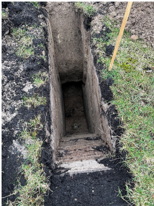
Bild 3: Bodenaufbau im Bereich Schurf S4
