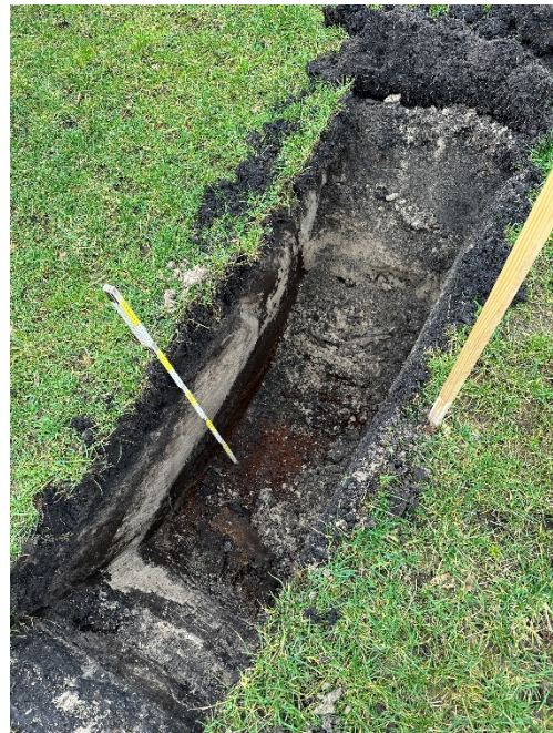
Bild 2: Bodenaufbau im Bereich Schurf S2
