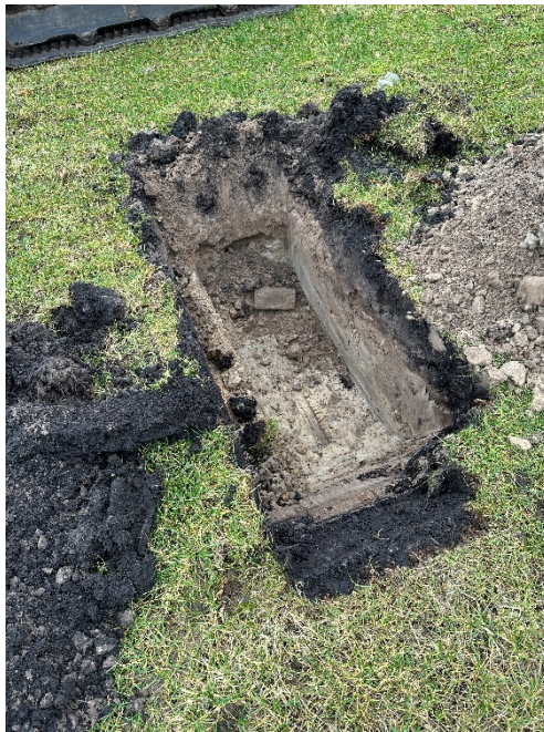
Bild 1: Bodenaufbau im Bereich Schurf S1
